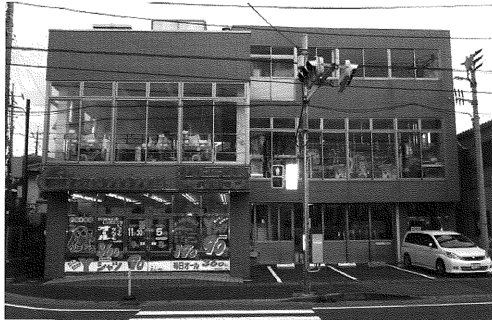
グローバル社のガラス張りの工場
